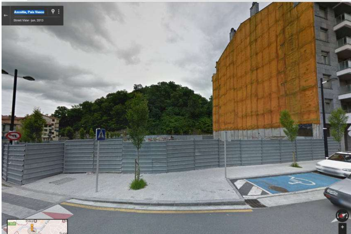
Encintado de aceras ejecutado en el entorno del Área 8.
