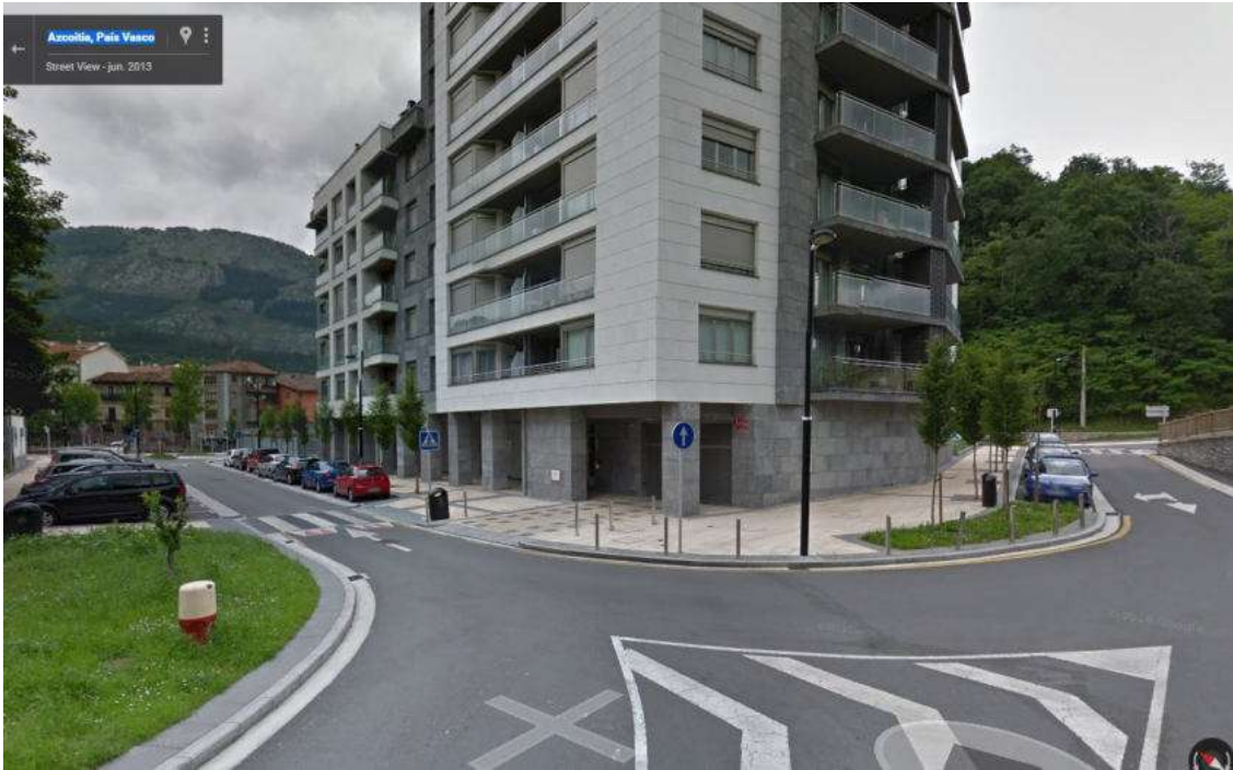
Urbanización ejecutada en el lindero noroeste de la parcela nº 4
